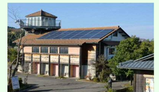
太陽光発電設備が設置されているエコビレッジ交流センター
