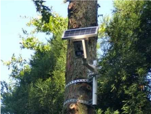
図 7-3-1 市内に設置している監視カメラ
