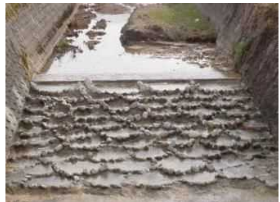
天王川に設置された水辺の小わざ魚道
