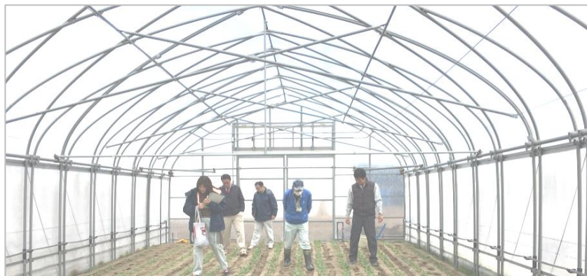
間口 6m、P径 31.8 mm、ピッチ 100 cm、トラス構造、X斜材補強
