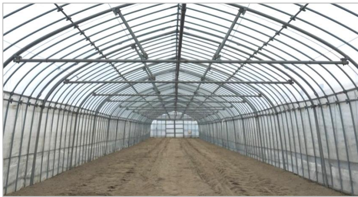
間口 5.4m、P径 25.4 mm、ピッチ 45 cm、P径 42.7 mmのアーチ+タイバー補強
