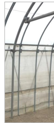
間口 5.4m、P径 25.4 mm、ピッチ 45 cm、P径 42.7 mmのアーチ+タイバー補強
