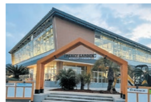
▲武生中央公園温水プール
