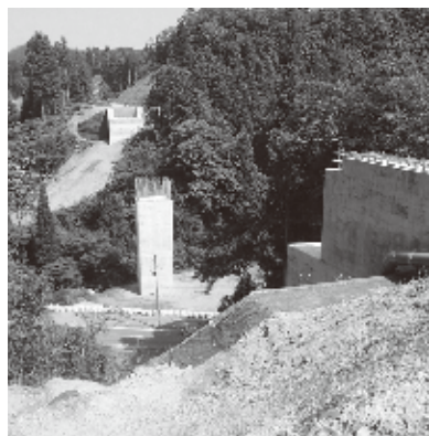
吉野瀬川ダム上流の付替え道路整備
