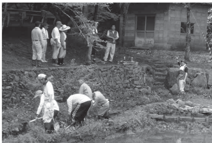
▲夫婦池再生作業風景
