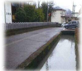
ガードレール設置
