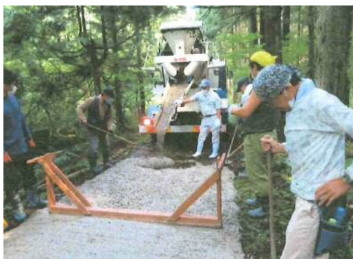
集落による林道維持活動（舗装施工）
