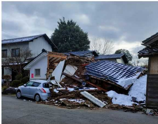
<能登半島地震で倒壊した木造住宅>
