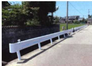
ガードレール設置
