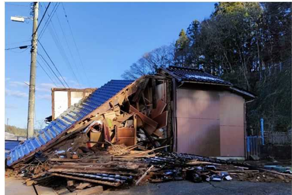
<能登半島地震で倒壊した木造住宅>
