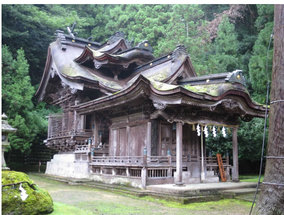
大瀧神社社殿(本殿及び拝殿) ※重要文化財
