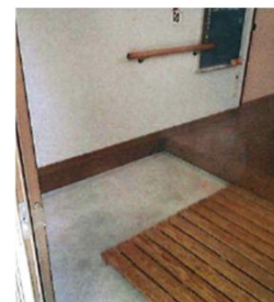
スロープ設置
