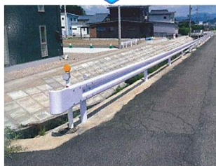
ガードレール設置
