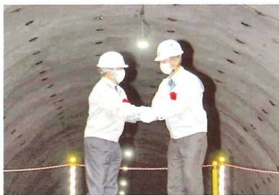
国道417号線 南坂下トンネル貫通
