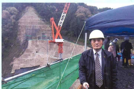
▲吉野瀬川ダム工事現場
