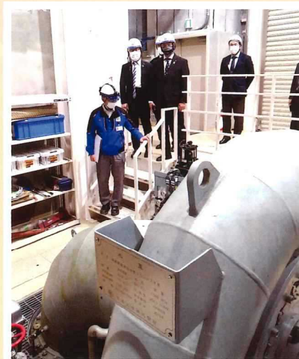
水力発電所へ視察（敦賀市足田）
