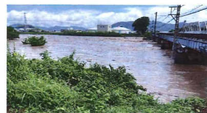
▲家久地係の日野川状況。これが氾濫したら、背筋が凍りました。
