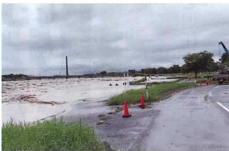
日野川右岸へ飯山橋交代橋
