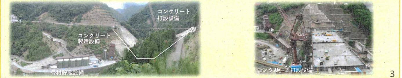
ダム用仮設備のイメージ (河内川ダムの事例)
