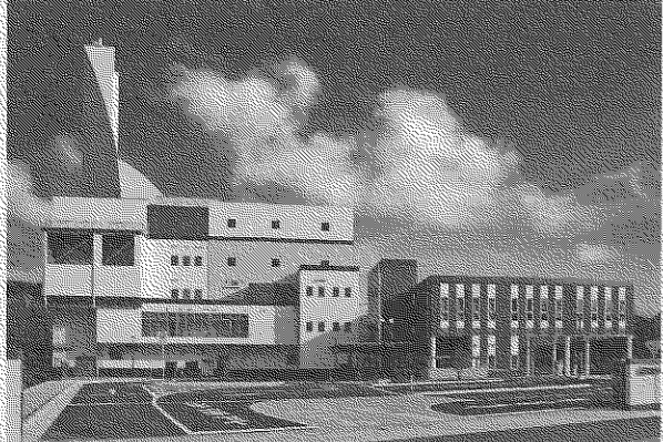
新ごみ処理施設 全景
