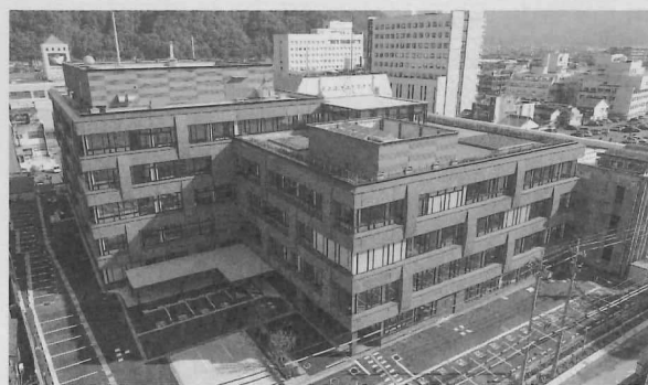
新庁舎 北西方向より
