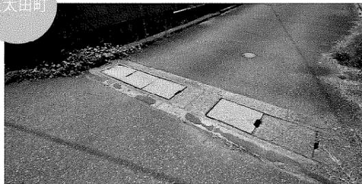
側溝のふたが破損し子どもの足が入るくらいの穴があったため、ふたを4枚交換した。
