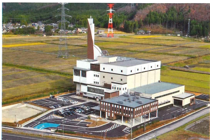
南越清掃組合第1清掃センター
