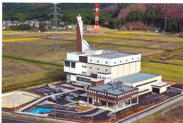
南越清掃組合第1清掃センター
