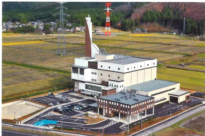
南越清掃組合第1清掃センター
