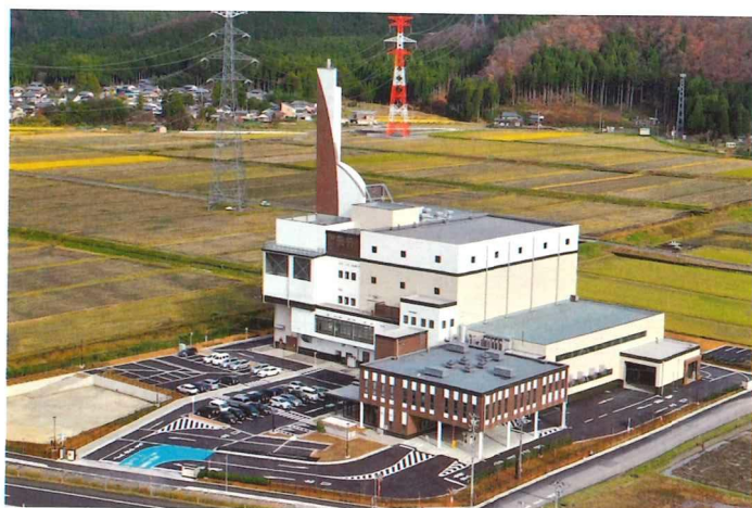
南越清掃組合第1 清掃センター
