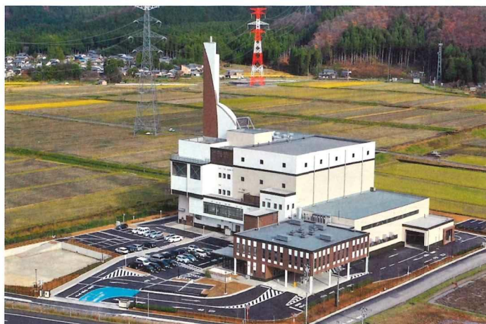
南越清掃組合第1清掃センター
