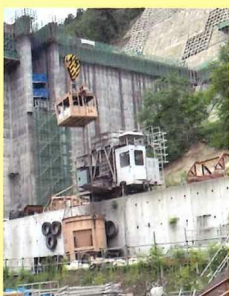
ダム本体の上流側の 建設現場にて
