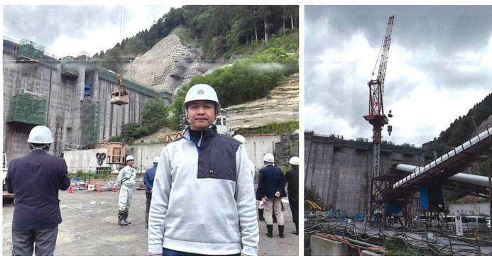
吉野瀬川ダム工現場へ
