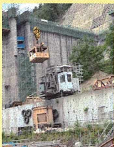
ダム本体の上流側の 建設現場にて
