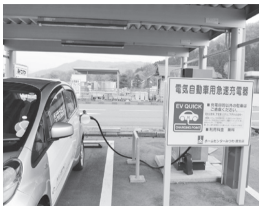
平成24年4月に市内で初めて設置された急速充電器
