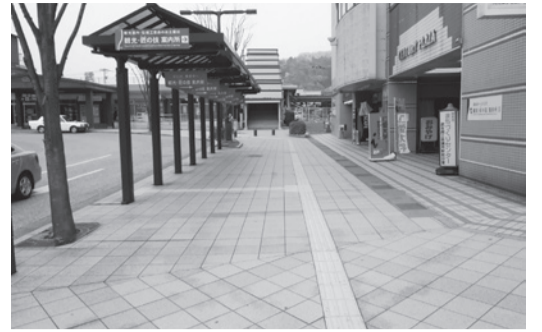
点字ブロックで整備された武生駅前歩道
