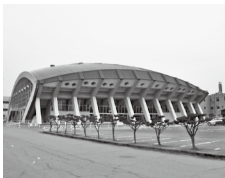
福井国体開催までに新たに建て替える予定の武生中央公園内の体育館
