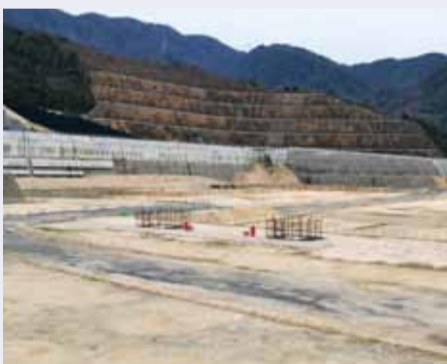
日本原電(株)敦賀発電所 3・4号機建設予定地
