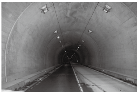
市が管理するトンネルの1つ武宮トンネル(安養寺地係)
