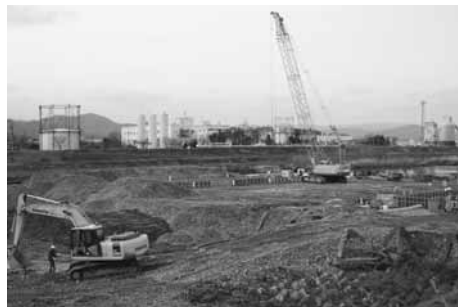
戸谷片屋線の日野川に架かる橋梁工事が始まる（瓜生町地係から河川敷を望む）
