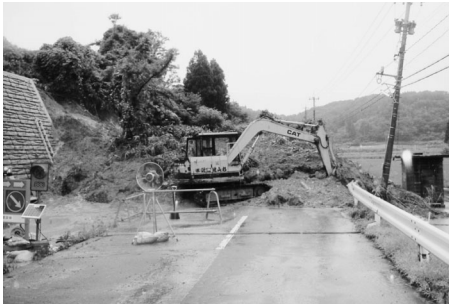
▲7月豪雨崖崩れ災害箇所(黒川町)
