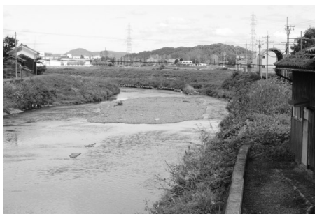
▲早期の改修が望まれる吉野瀬川(大正橋下流)
