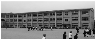
▲改築される南中山小学校校舎
