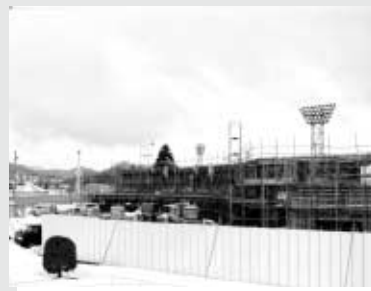
建設が進む新図書館(武生中央公園内)
