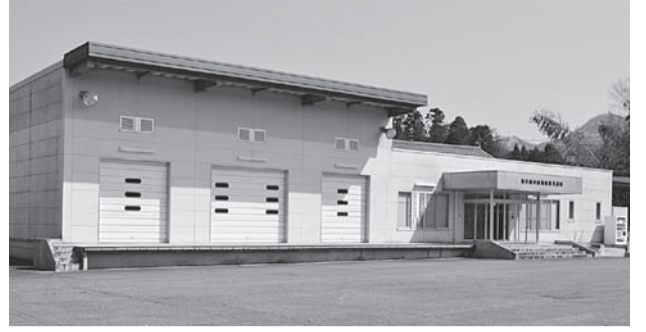
東運動公園にある福井県丹南地域防災基地
