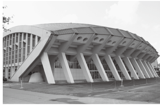
バリアフリーの改修がされる武生中央体育館
