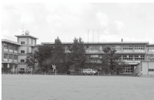
太陽光発電装置が設置される武生南小学校
