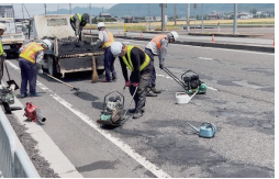
▲国道8号線を修繕している状況
