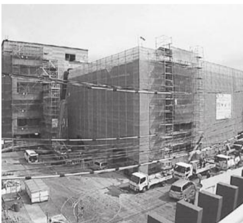
建設が進む新庁舎
