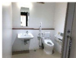
多目的トイレ （児童館と共用）
