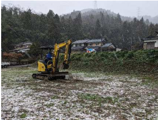
試掘調査 作業風景
