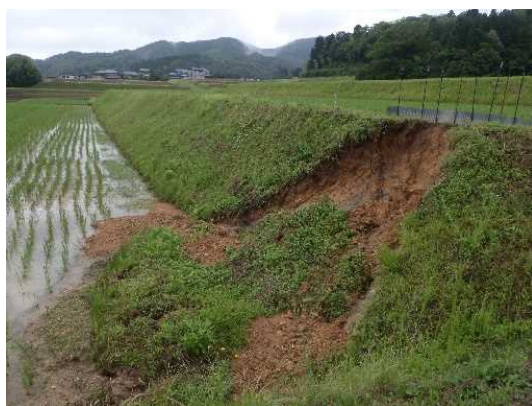
側溝の損傷
