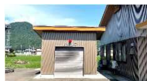
▲新しく防災倉庫に
