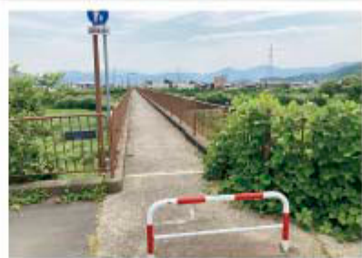
南越線後の八幡歩道橋
