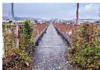
八幡1・2丁目からの入り口。長さ：約170m、巾：2m。橋脚が7つあり、その中の3つが当時造られたものです。
