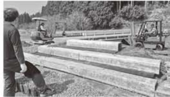
完成した階段状のプランター置き場
