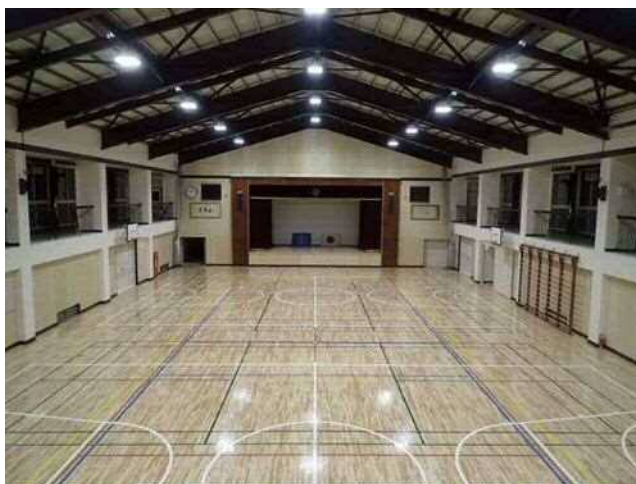
味真野小学校屋内運動場改修工事
