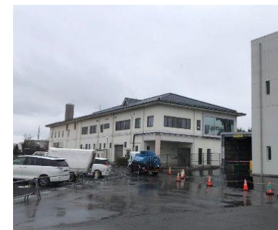
し尿処理施設(解体完了)
