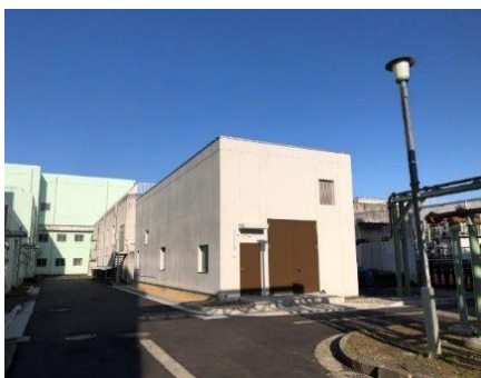
機械濃縮施設
