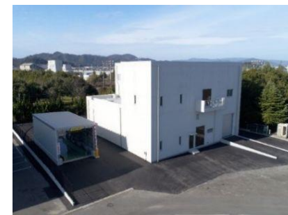
汚泥前処理施設
