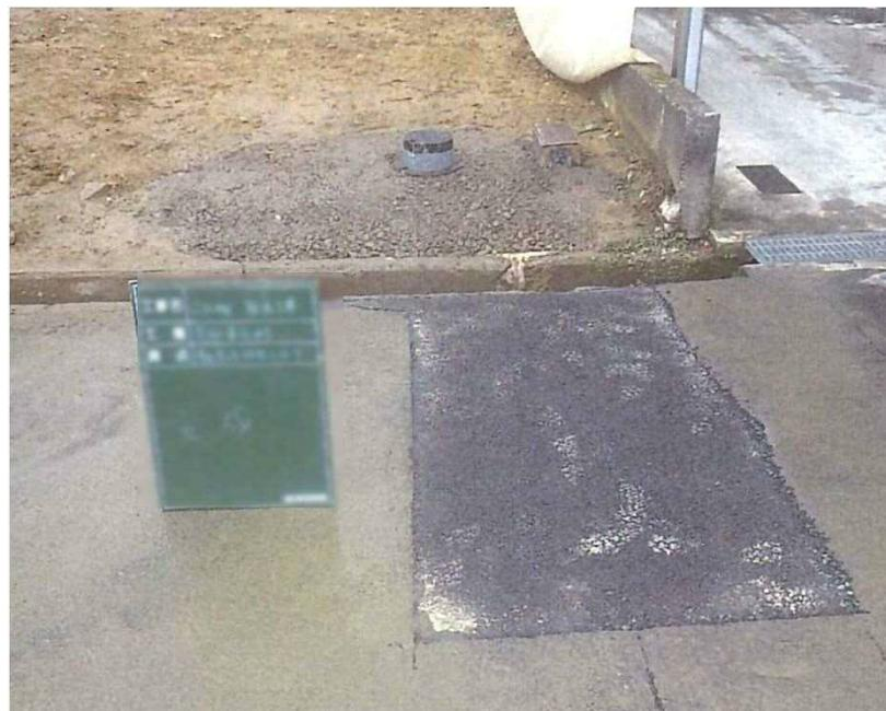
宅地造成などで、建物が建つ時期が未定の場合には、公共柵の蓋の高さを道路の高さより上にしないでください。除雪の際に破損する事例が多くなっています。
