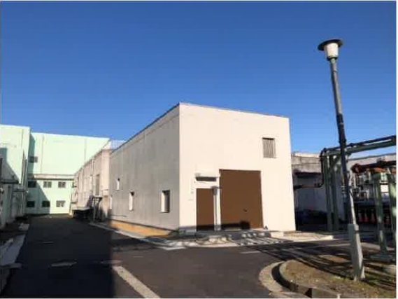
図2 機械濃縮施設
