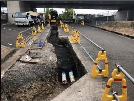
図.4 圧送管の布設工事状況
