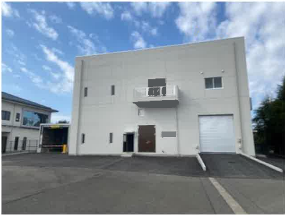
図.3 汚泥前処理施設
