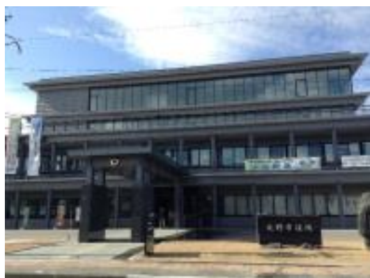
大野市役所外観
