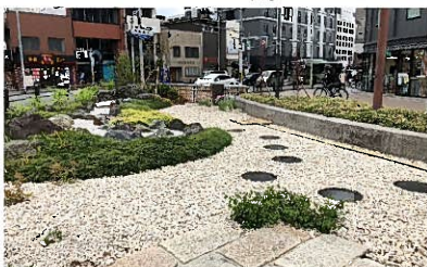
交差点に設置された雨庭(京都市)
