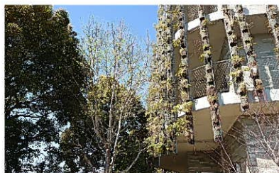
施設周りの高木と立体的な壁面緑化 (特別養護老人ホーム愛成園 (横浜市))
